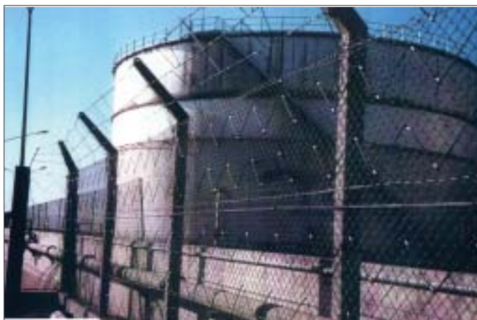
Фото 3. Нефтехранилища, защищенные системой охраны периметра
